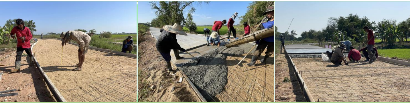
วันอาทิตย์ ที่ 22 มกราคม 2566 นายสุวิทย์ เพ็งเมืองนนท์ นายช่างโยธาผู้คุมงานและคณะกรรมการ ตรวจการจ้าง ลงพื้นที่ตรวจการจ้างถนนคอนกรีตเสริมเหล็ก หมู่ที่ 5 บึงอีแลน
