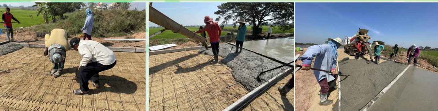
วันอังคาร ที่ 24 มกราคม 2566 นายสุวิทย์ เพ็งเมืองนนท์ นายช่างโยธาผู้คุมงานและคณะกรรมการ ตรวจการจ้าง ลงพื้นที่ตรวจการจ้างถนนคอนกรีตเสริมเหล็ก หมู่ที่ 5 บึงอีแลน
