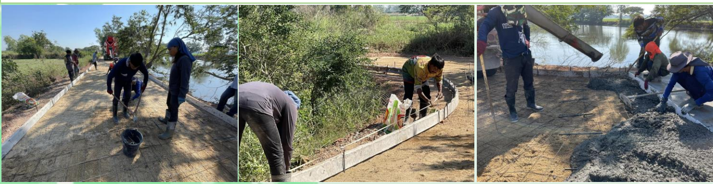
วันอังคาร ที่ 17 มกราคม 2566 พนักงานจ้าง กองช่าง ลงพื้นที่ดำเนินการตัดแต่งกิ่งไม้ หมู่ที่ 9 เพื่ออำนวยความสะดวกให้กับประชาชน
